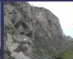
Estabilización de taludes
